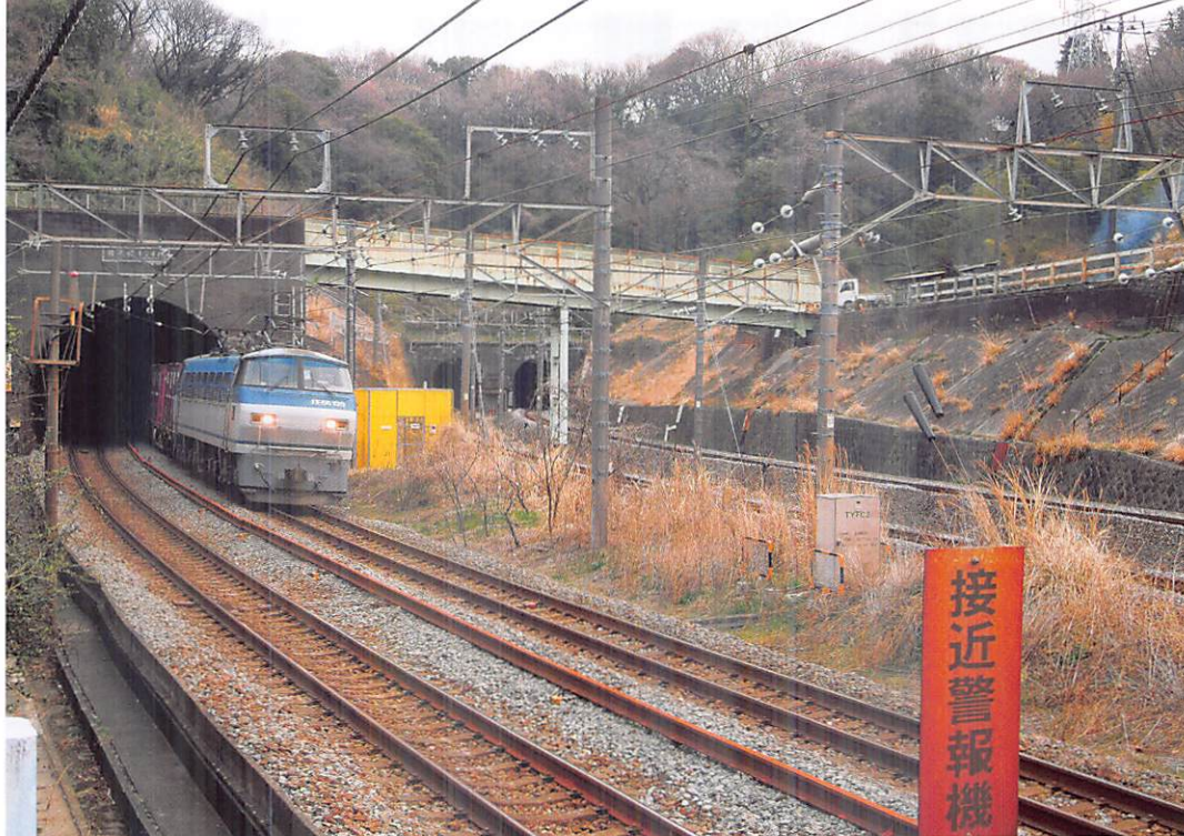
猪久保トンネル・右は品濃トンネル(品濃町)
